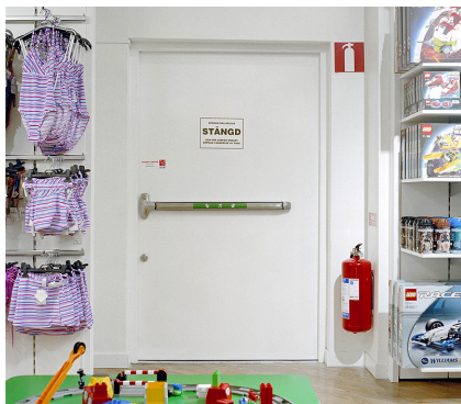
Sikkerhedsdør S33 med panikrigel, magnetkontakt og mikroswitch i låsen ses ofte i butikker
